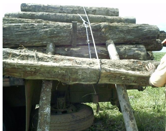
Fotos 7.11 e 7.12 - Exemplo de operação de retirada de madeira em área de bacia hidráulica. O carregamento de toros e toretes é feito com guincho e a madeira deve ser presa ao caminhão por meio de cabos adequados. Os resíduos são enleirados para extração ou queima após a retirada da madeira (Fotos: Arquivo Consórcio ENGECORPS♦FLORAM).
