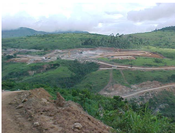
Foto 12.1 e 12.2 - Exemplos de área com supressão mínima e gradativa de vegetação em canteiro de obras de barragem, nas margens esquerda e direita do rio. A vegetação de mata ciliar (m. direita) foi mantida até por ocasião da finalização do desvio do rio e da margem esquerda (foto esquerda), não foi retirada. (Fotos: Arquivo do Consórcio ENGEORPS♦FLORAM).
