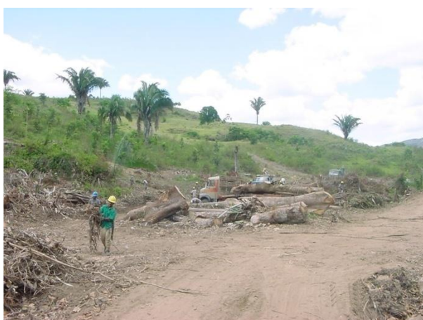
Fotos 7.11 e 7.12 - Exemplo de operação de retirada de madeira em área de bacia hidráulica. O carregamento de toros e toretes é feito com guincho e a madeira deve ser presa ao caminhão por meio de cabos adequados. Os resíduos são enleirados para extração ou queima após a retirada da madeira (Fotos: Arquivo Consórcio ENGECORPS♦FLORAM).
