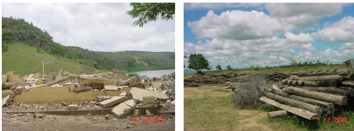
Foto 8.1 e 8.2 - Demolição de benfeitorias; os entulhos da construção poderão permanecer na área, mas os materiais aproveitáveis devem ser removidos para reutilização (Fotos de Arquivo Consórcio ENGECORPS-FLORAM)
