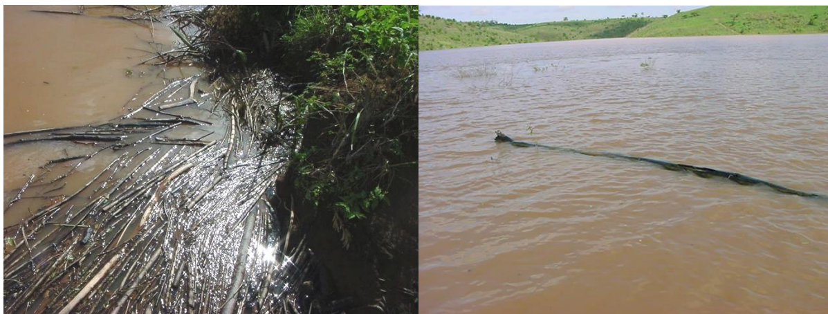
Foto 10.1 e 10.2 - Início do enchimento de um reservatório apresentando água com muitos sólidos suspensos e resíduos flutuantes, que no reservatório de Projeto Hidroagrícola Jequitaí deverão ser retirados se vierem a ocorrer (Fotos: Arquivo Consórcio ENGECORPS♦FLORAM).
