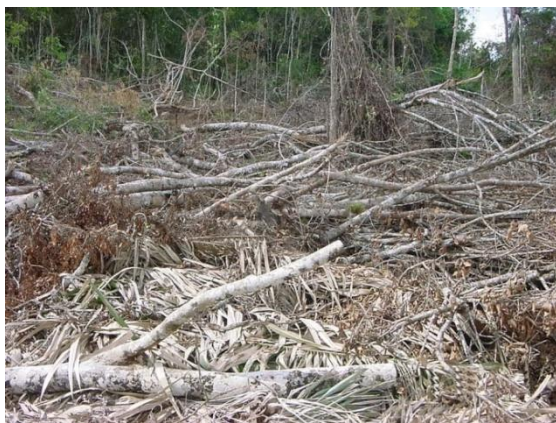
Fotos 7.3 e 7.4 - Resultado do corte e derrubada da vegetação em área de bacia hidráulica em regiões florestadas. As pontas de corte não devem permanecer nos tocos para evitar acidentes durante a limpeza e após o enchimento do reservatório. (Fotos: Arquivo Consórcio ENGEORPS♦FLORAM)
