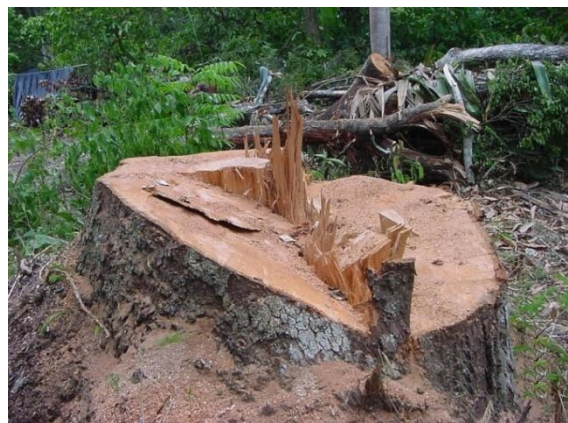
Fotos 7.3 e 7.4 - Resultado do corte e derrubada da vegetação em área de bacia hidráulica em regiões florestadas. As pontas de corte não devem permanecer nos tocos para evitar acidentes durante a limpeza e após o enchimento do reservatório. (Fotos: Arquivo Consórcio ENGEORPS♦FLORAM)
