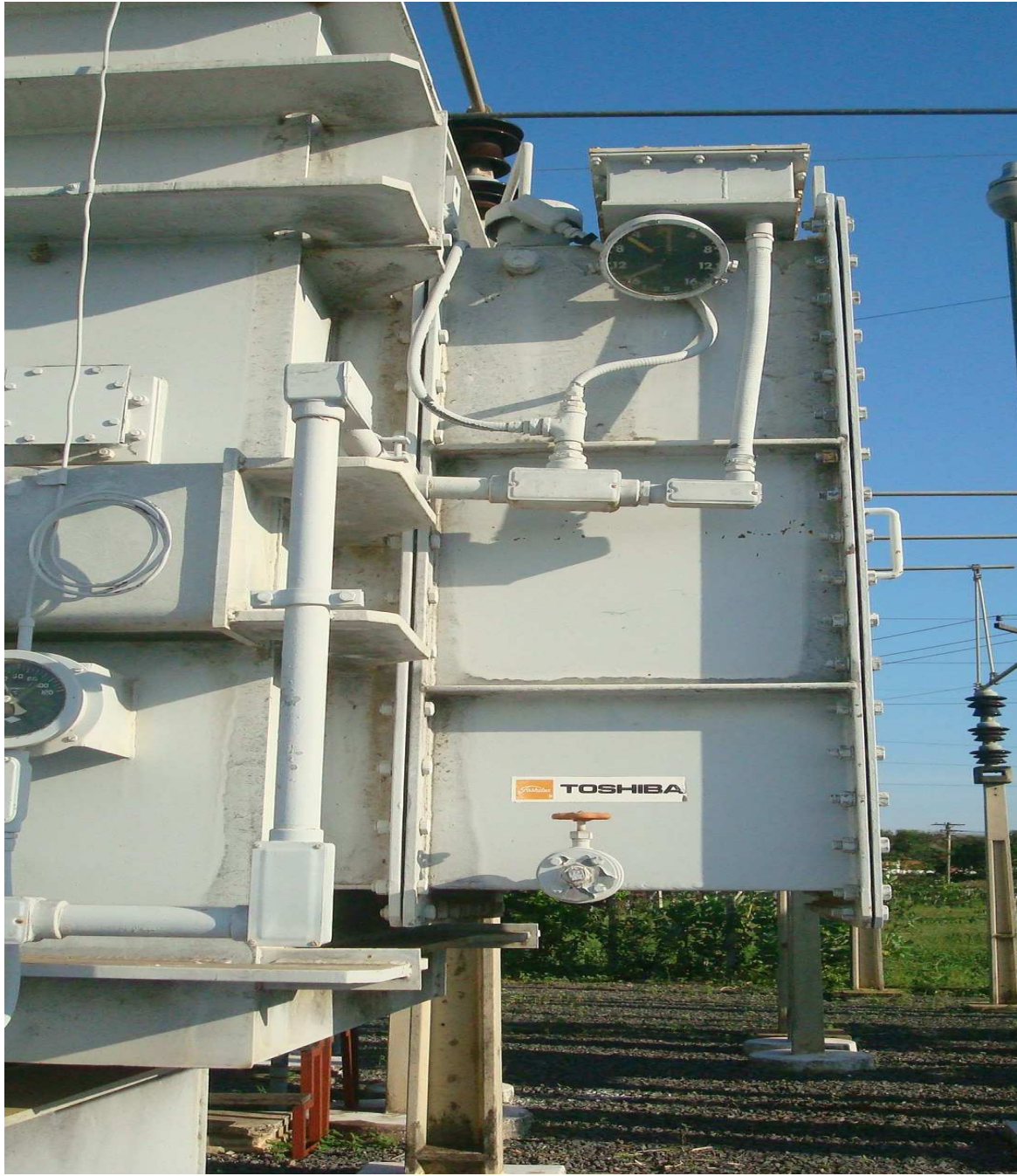
FOTO 08 : VISTA LATERAL COMUTADOR DO TRAFÓ 138 KV DA SE EB-1
